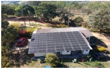
Solaranlage auf dem Dach
