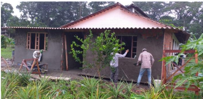
Anbau für den neuen Friseursalon
