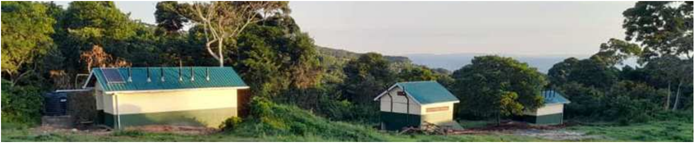
Trockentoilettenanlagen in Kinyo
